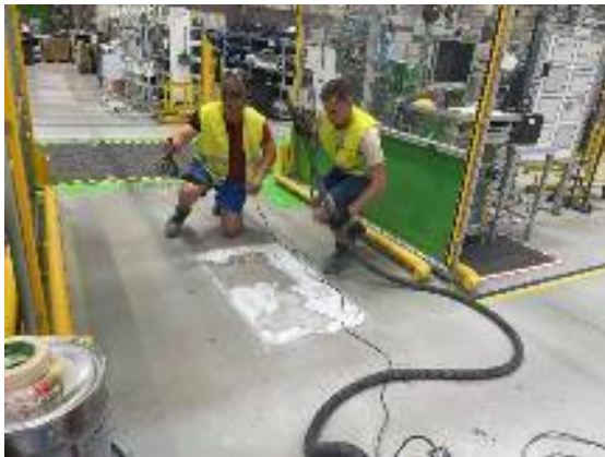
Saválló műgyanta vastag-bevonat készítés parketta gyár szárító kamrájában
