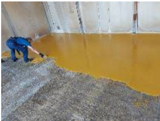
Saválló műgyanta vastag-bevonat készítés parketta gyár szárító kamrájában
