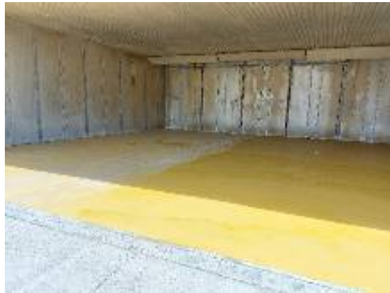
Saválló műgyanta vastag-bevonat készítés parketta gyár szárító kamrájában
